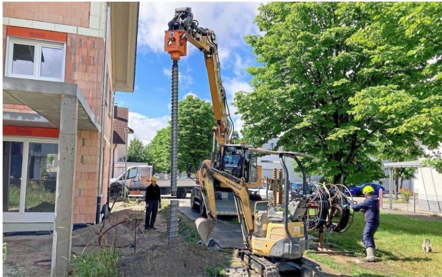
Ins Erdreich schraubt sich die Bohrschnecke, hier auf einer Baustelle in Oberhausen-Rheinhausen. In die Schlotte werden die Erdsonden verlegt und mit einer Wärmepumpe im Haus verbunden. Foto: Nicole Jannarelli
